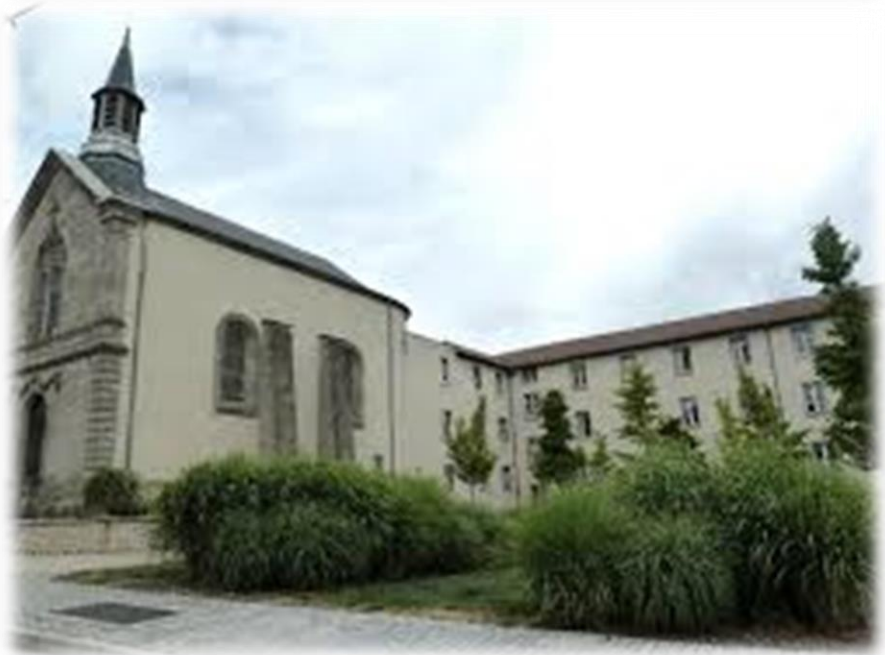
Ancienne chapelle de l'hôpital Saint-Alexis
